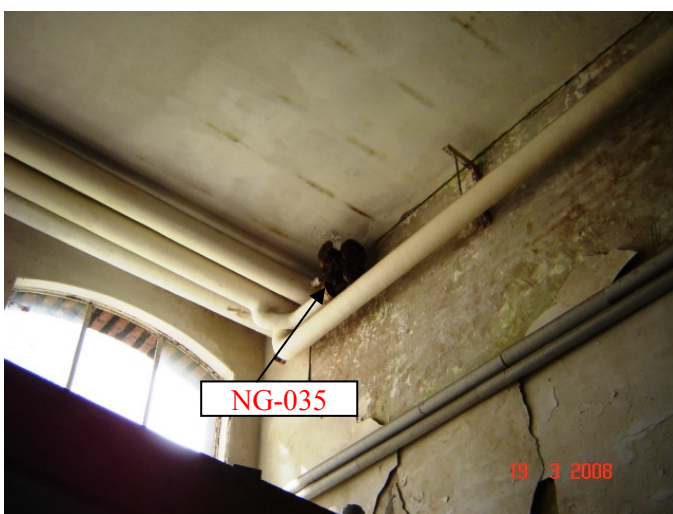
Foto 33 pakking flensverbinding
