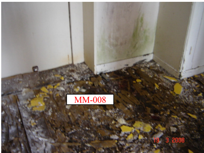
Foto 6 restanten plafond (vervuild met isolatie)
