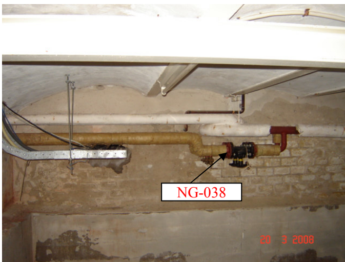
Foto 35 pakking flensverbinding
